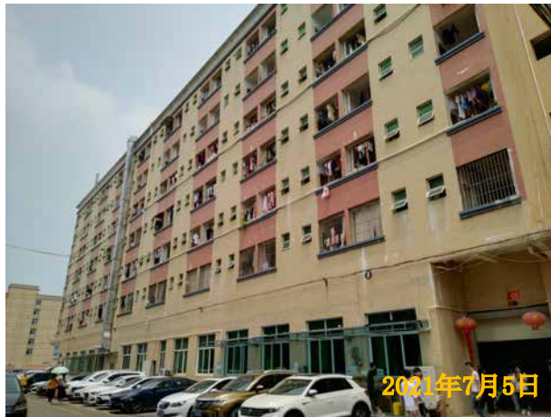
项目北面工业区宿舍
