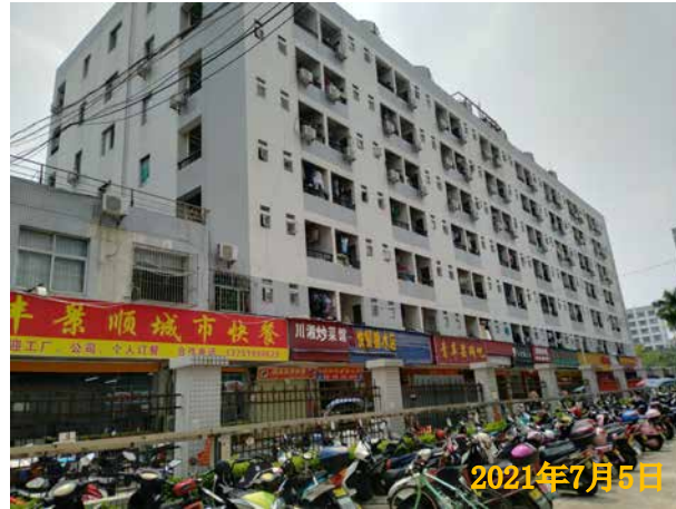
项目东面工业区宿舍
